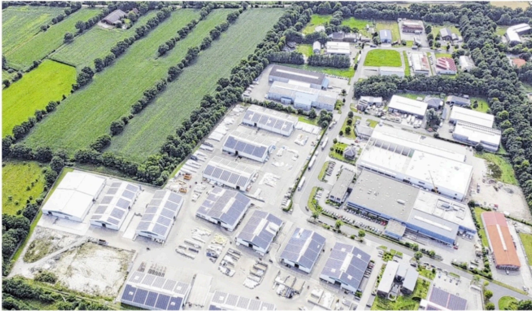
Östlich des derzeitigen Firmengeländes im Gewerbegebiet Schirum, hier im linken oberen Bereich, entsteht die große Erweiterungsfläche mit einer Windkraftanlage von Enercon.
